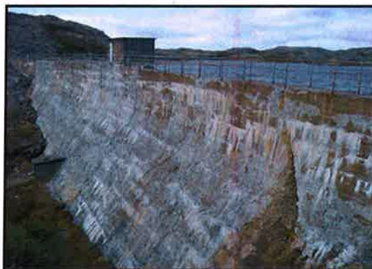
Barrage de la Vigie – photo DTAM
