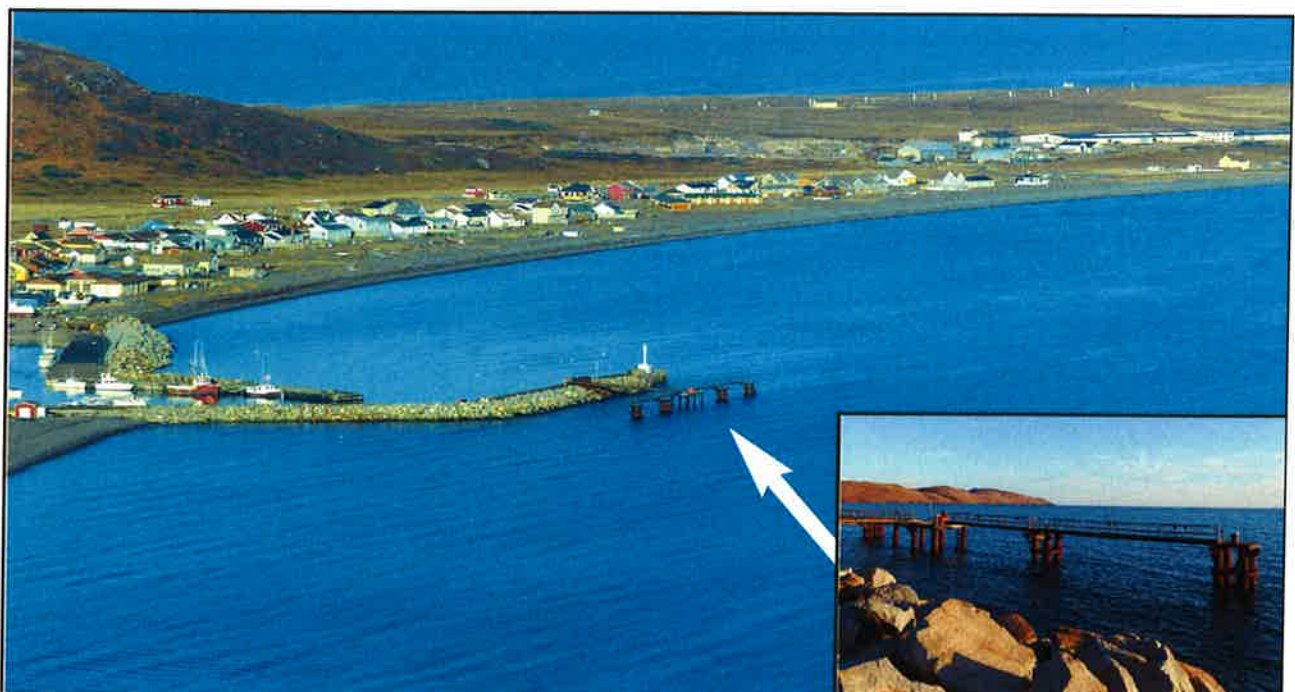
Appontement pétrolier de Miquelon - Photos : Préfecture
